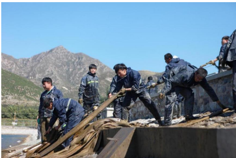
图 京燕公司为沉砂池更换新的漂浮,保证水质净化降浊
