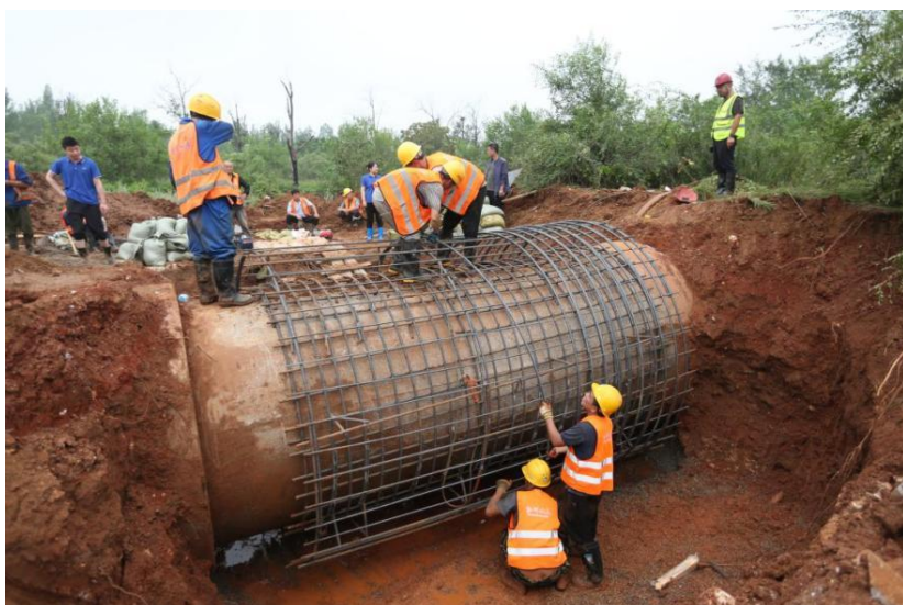
图 张坊供水损毁管线、设施抢修
