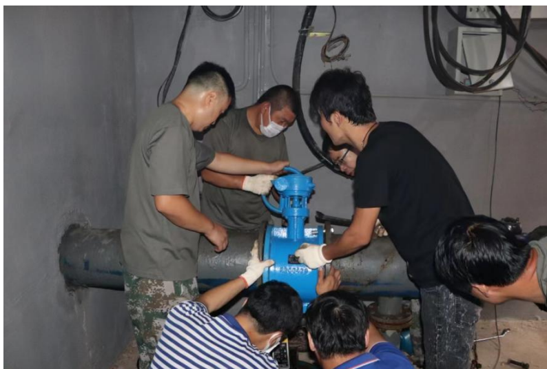
图 京燕公司更换老旧设备以达到节能减耗目的
