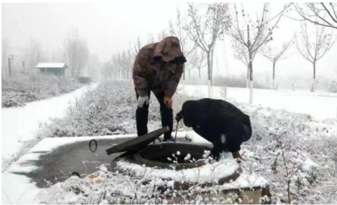
图 供水管线巡线检查，确保供水安全
